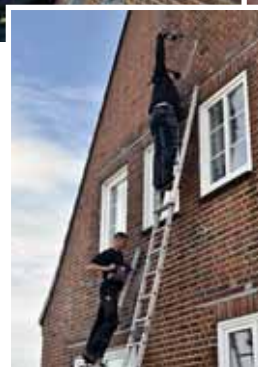
Nach Untersuchung der Wandstärken wird das Dämmmaterial über Bohrungen in die Zwischenwände eingebracht (Fotos: Adam's Bautenschutz).
