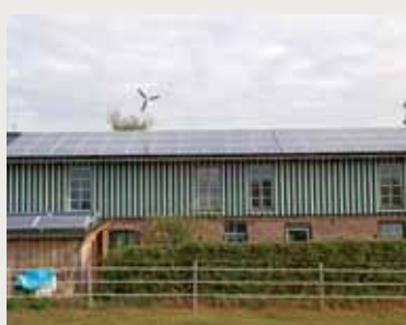
Komplette Dachsanierung mit PV-Anlage
