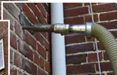
Nach Untersuchung der Wandstärken wird das Dämmmaterial über Bohrungen in die Zwischenwände eingebracht (Fotos: Adam's Bautenschutz).
